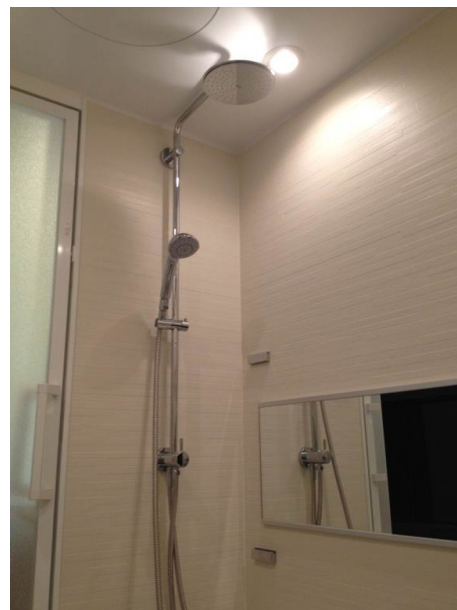
シャワーシステム設置完了
